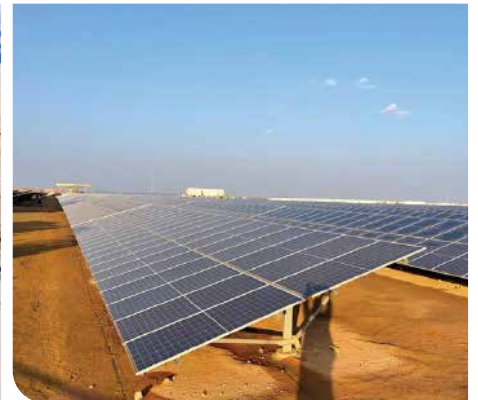
الألواح الشمسية في مشروع منصورة-مسرة
